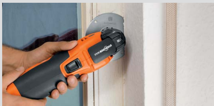
Protnutí kovových upevňovacích pásků při demontáži starých oken.
