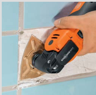
Rovinné obroušení lepidla na dlaždice před opětovným vyspárováním.
