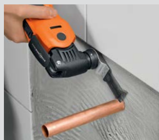
Řezání rovnoběžně se stěnou na minimálním prostoru.
