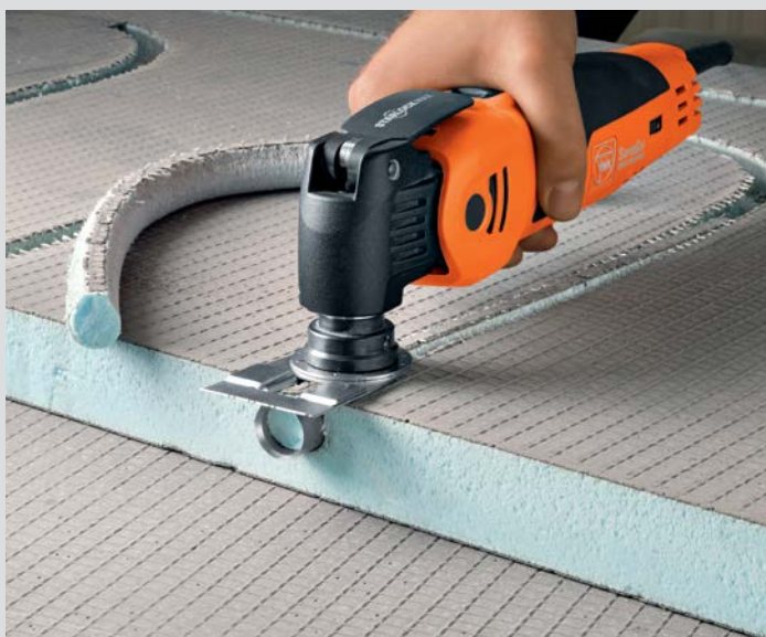
Výřezávání kanálů pro potrubí teplovodního podlahového topení.
