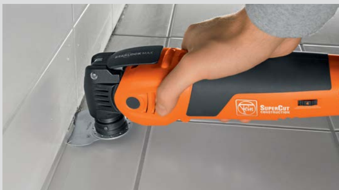
Odstraňování spárovacích těsnících hmot.
