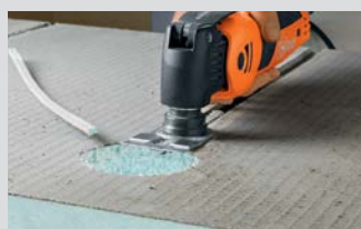
Příprava elektroinstalace.
